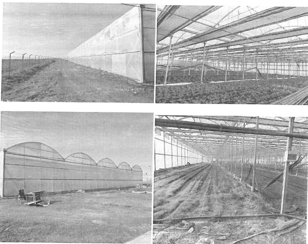
Sera de legume situată în Comuna Iecia Mare înscrisă în CF în suprafață de 10.094 mp, în regim de construcție parter, pe structura metalică din profile laminată zincată acoperită cu folie de polietilenă în dublu strat cu ventilație, dotată cu centrala termică și stație de pompare, 2 puțuri forate pentru alimentarea cu apă, bazin colectare ape pluviale, stație meteo, împrejurire;
